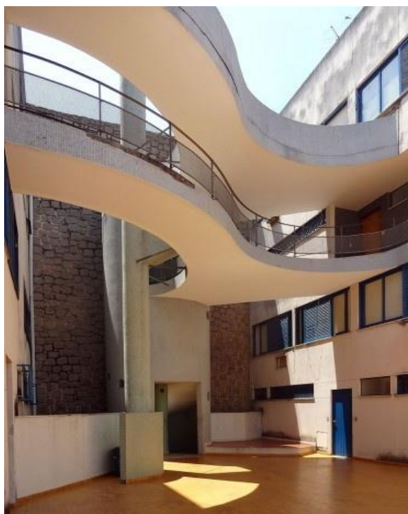
Edifício Nacional Fonte: Vitruvius.com.br
